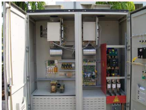
STATCOM – 3Ph 3Wire 440V, 180 kVAr
