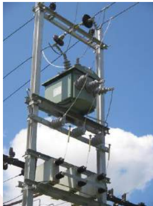
Automatic Capacitor Switch 11kV, 600 kVAr
